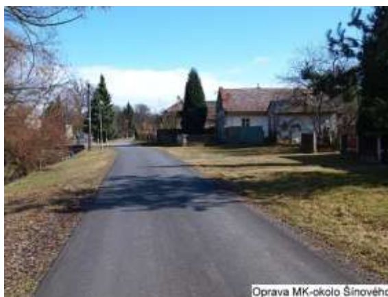
Oprava MK-okolo Šínového.
